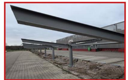
*Beispiel für großen CO<sub>2</sub> Verbrauch durch überzogene Dimensionierung von Stahlträgern. Wir versuchen, neue Wege zu gehen und sowohl die Ästhetik auch bei industriellen Projekten zu beachten, als auch den Ressourcenverbrauch zu reduzieren durch eine Optimierung der Dimensionierung der Stahlteile.*
