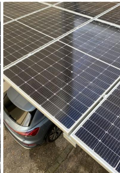
Ein zentrales Element beider Serien sind die Doppelglasmodule, die nach EN12600 für Überkopfmontage zertifiziert sind. Diese Zertifizierung stellt sicher, dass die Glasmodule höchsten Sicherheitsstandards entsprechen und für die Verwendung über Kopfhöhe geeignet sind.
